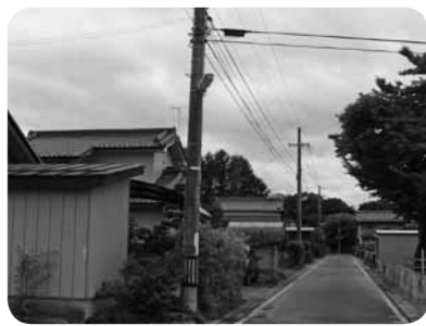
設置が進む防犯灯
