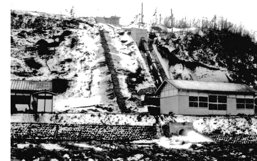
▲完成直後の発電所(「佐久市平根発電所」パンフレットより)
