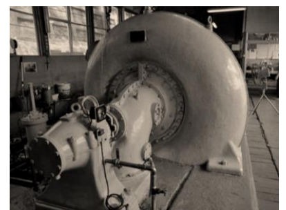
▲平根発電所に設置されている水車
