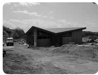
建設中の交流棟
