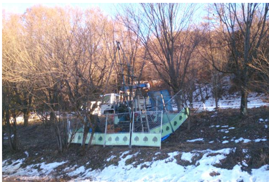
▲ 追加地質調査(ボーリング調査)の様子
