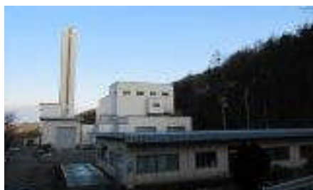
▲川西清掃センター（現行施設）
