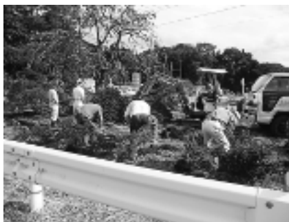
実施作業中。9月上旬から草刈などを始め、10月に植栽が完了しました。
