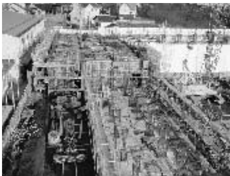
管理教室棟建設風景
