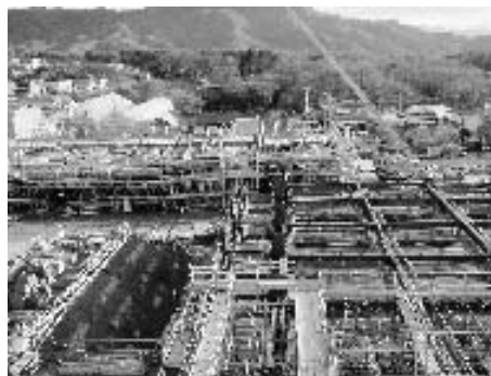
教室棟・体育館棟建設風景
