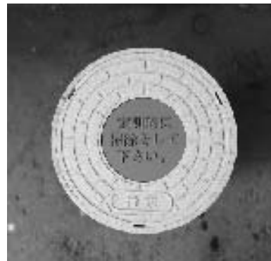
汚水マス写真
