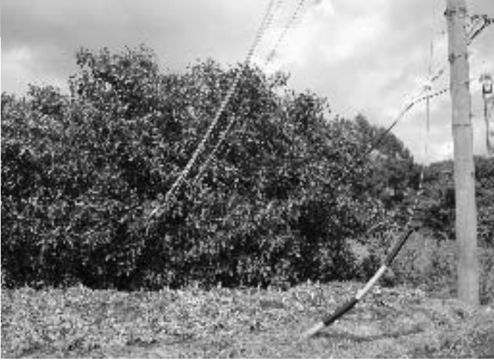
昨年の台風で、倒木により断たれる電線
