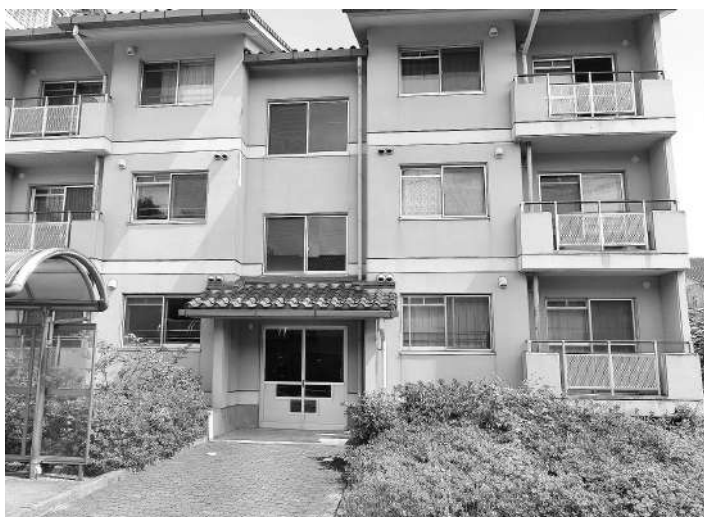
桜ヶ丘団地はエレベーター設置が難しい。
