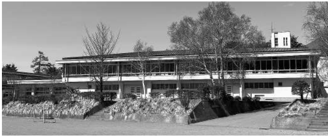
小学校体育館の冷房設備設置が進む。
