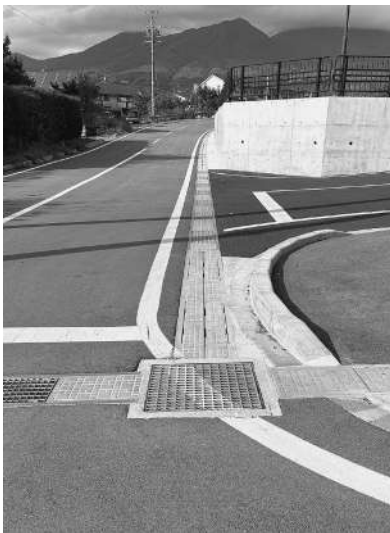
町内に整備されている標準的な道路側溝。
