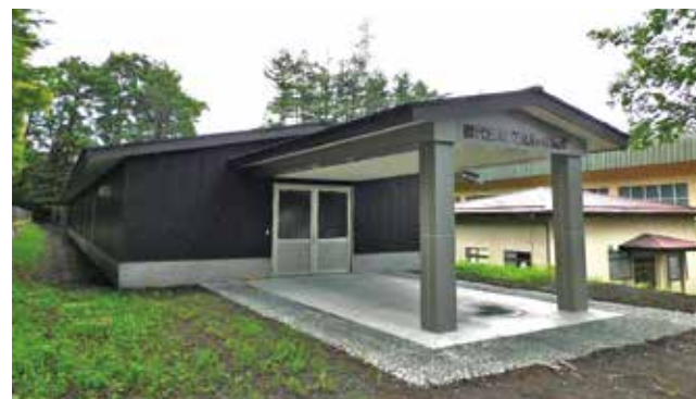
完成した文化財収蔵庫
