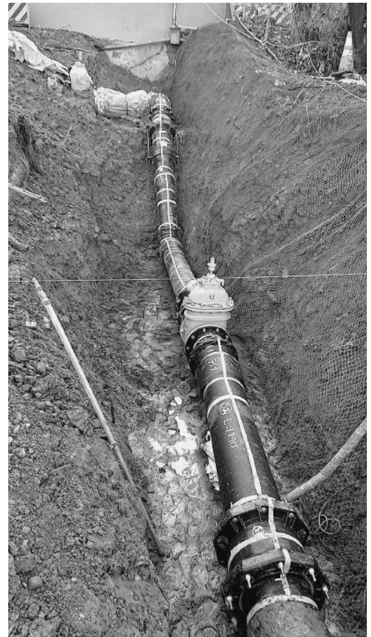
町内の上水道耐震管布設工事の様子。
