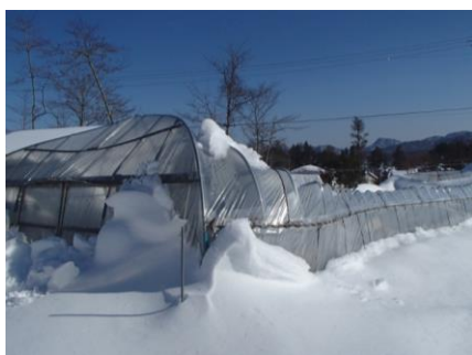
(農業用施設被害状況)
