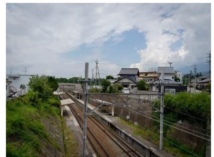
北側からは直接改札口にアプローチできない御代田駅
