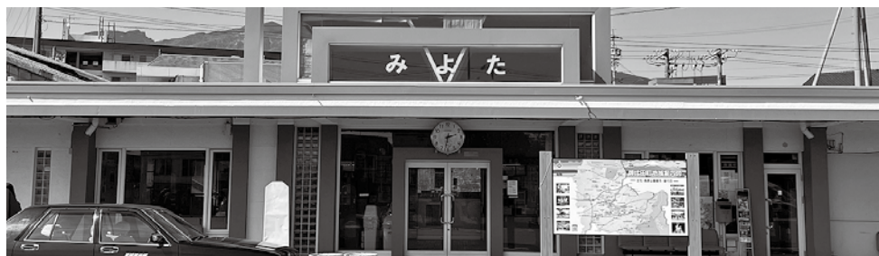
平成30年には外壁塗装などの修繕
