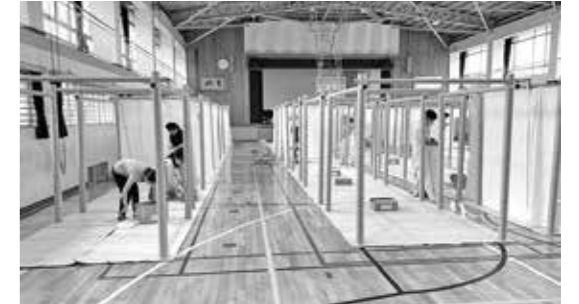
避難所組み立て中
