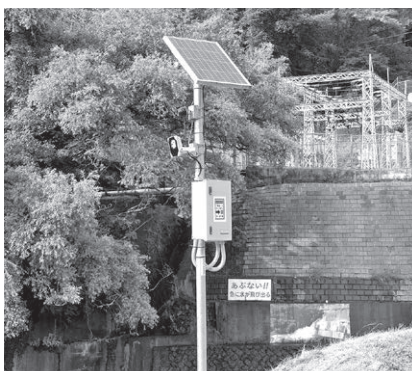
河川監視カメラ
