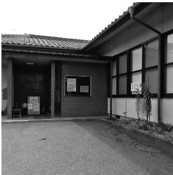
「みよたの輪」が実施されていた向原公民館
