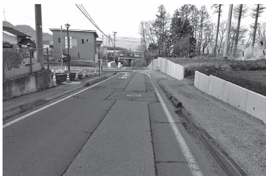
道路改良中の町道七口線
