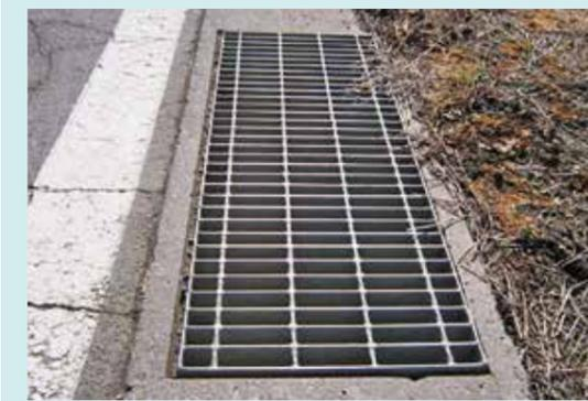
※御代田町が町道に設置するグレーチングは、基本的に「落とし込み式」か「ボルト固定式」です。
