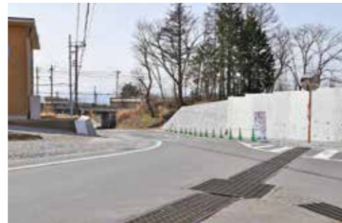
道路拡幅工事 (しな鉄アンダーパス付近)
