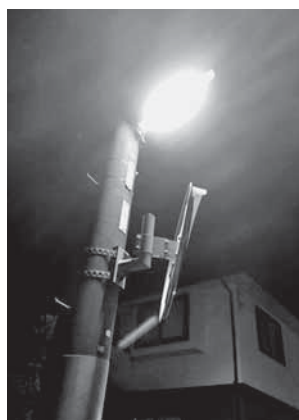
電柱に設置された防犯灯
