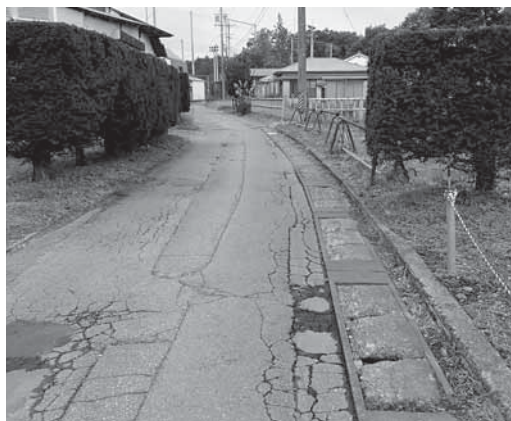
改善が必要な生活道路
