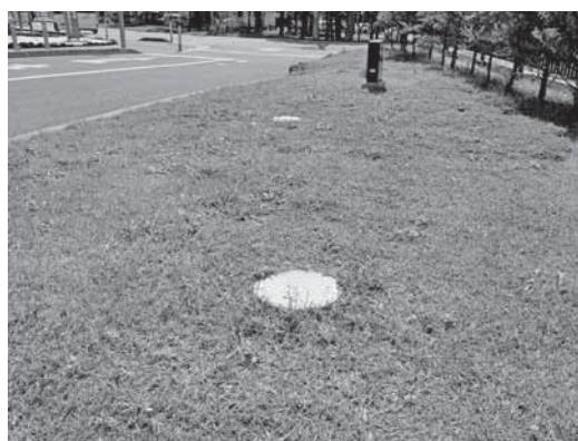
避難時トイレ用マンホール
