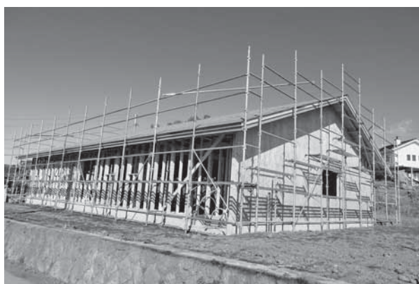
開園予定の新規保育園工事
