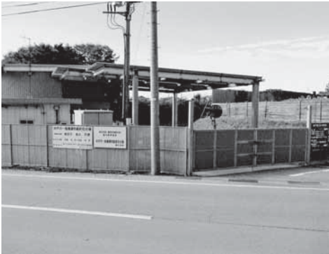
井戸沢最終処分場
