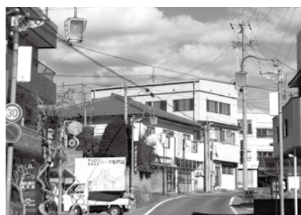
LED化にする各区の防犯灯
