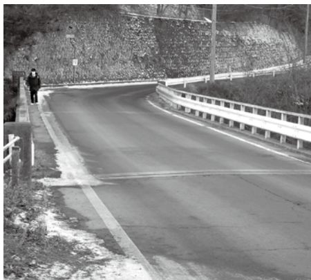
補修を待つ露切橋
