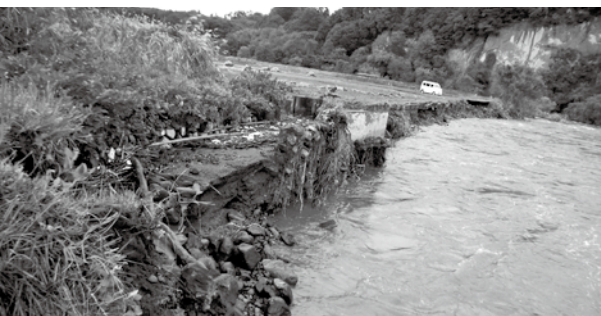
台風19号被災現場
