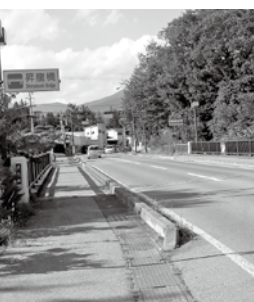
補修完了の昇龍橋
