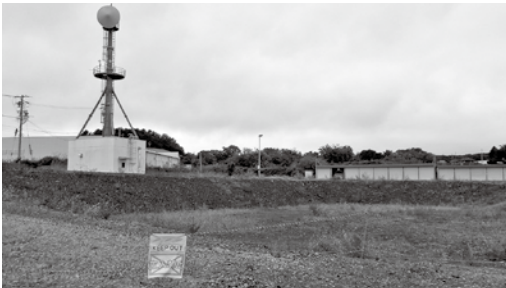
整備された庁舎跡地
