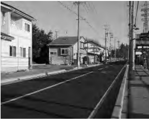
ガードより東側の多くが停電となった(シチズン通り)
