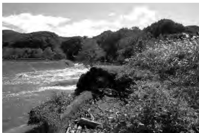
崩落した用水の取入口
