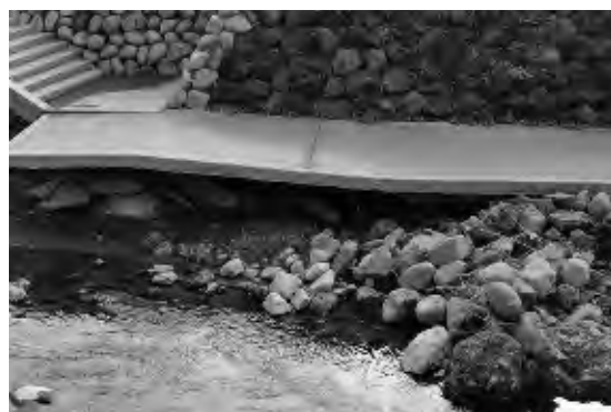
崩落した護岸
