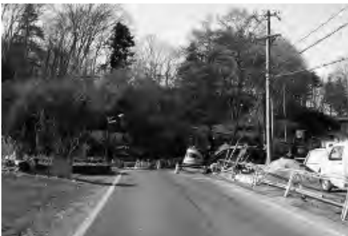
国庫補助事業工事現場
