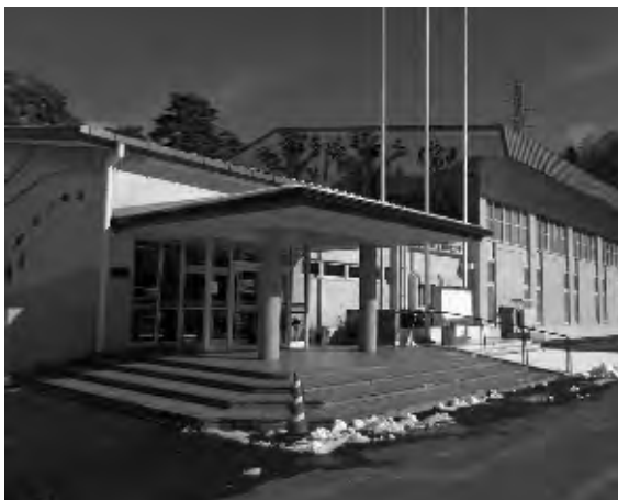
築39年を経過したB&G海洋センター
