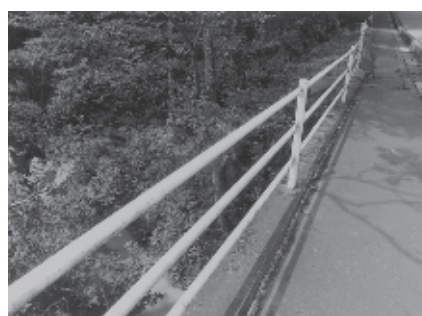
この場所には不安なガードパイプ
