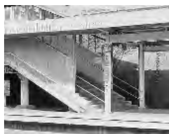
エレベーター設置が望まれるホーム
