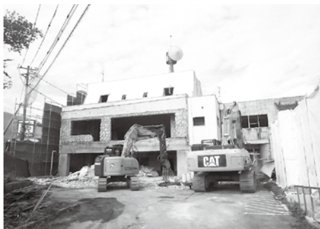
解体工事の様子
