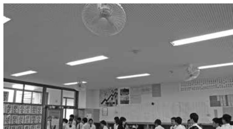
設置された天井用扇風機
