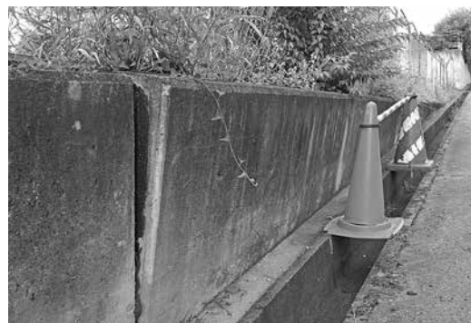
調整池の擁壁
