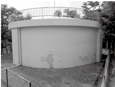
修繕必要な配水池
