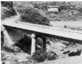
露切橋竣工 (S39年)
