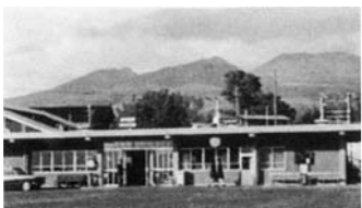
御代田駅竣工 (S46年)
