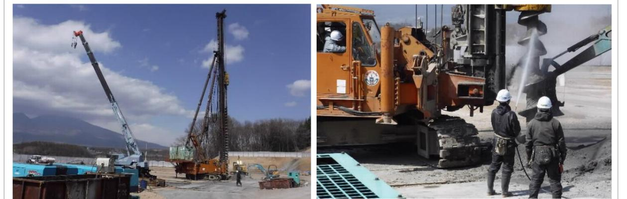
▲H30.4.10 撮影：現在「山留<sup>やまどめ</sup>工事」を行っています。写真はごみピットを掘削するにあたり土砂が崩れないようにする作業の様子です。また、土埃が飛散しないよう散水も徹底して行っています。
