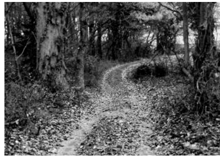
荒廃した農道
