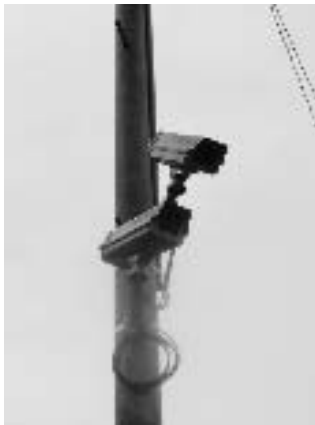
設置した監視カメラ
