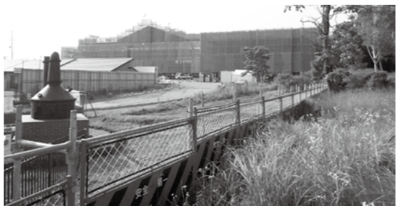
建設中の新庁舎
