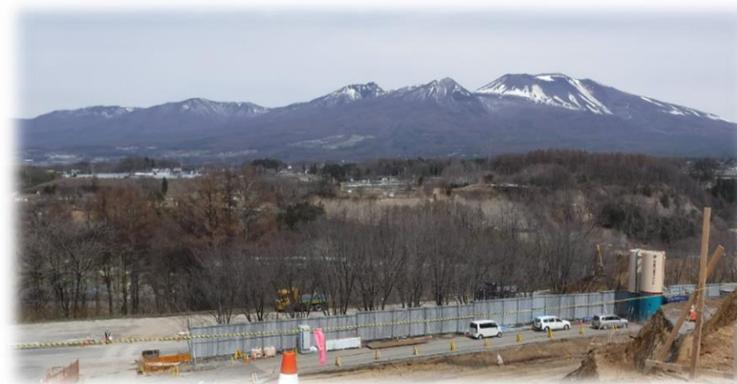
▶新クリーンセンター建設予定地から望む浅間山 [H29.4.10 撮影]
