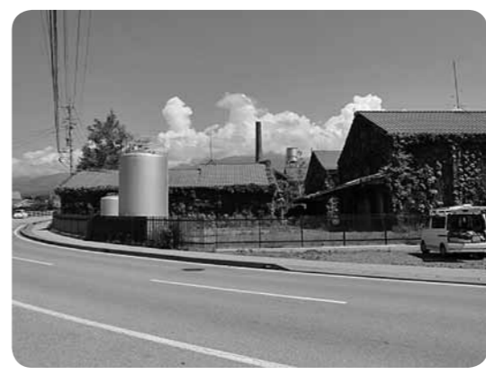
解体予定の建物群
