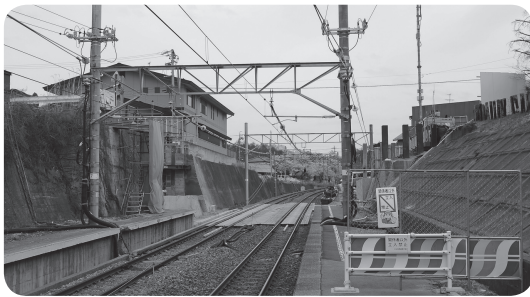
工事中の栄橋
