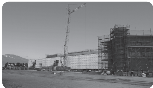
建設中の佐久医療センター
