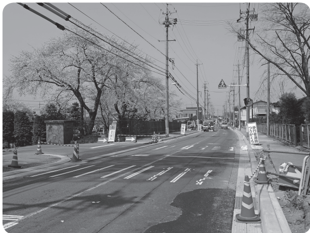
完成間近の雪窓向原線
