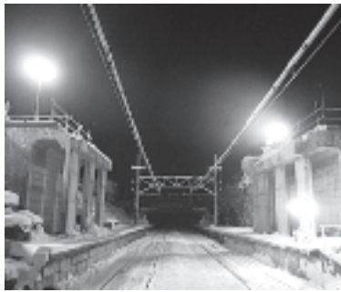
車道橋撤去後の様子
