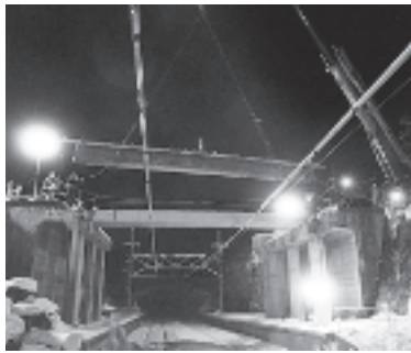
車道橋撤去の様子
