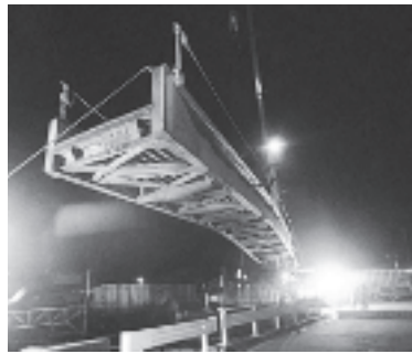
人道橋撤去の様子
