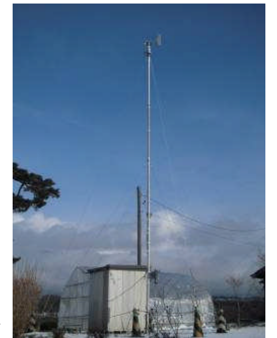
▲面替区上尾崎に設置された風向風速計
