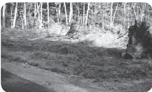
造成中の土地
