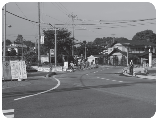
道路改良工事（駅北駐車場前）
