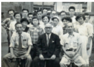
設立当時の板橋工場
