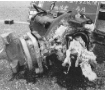
ゴミなどが詰まったポンプ
