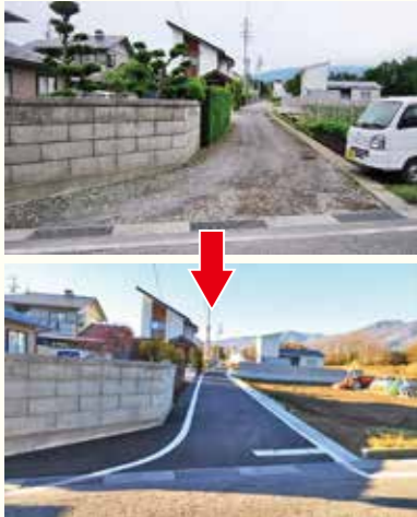
上橋沢2号線 道路改良工事(栄町地区) 幅員3.6m 延長 94.0m
