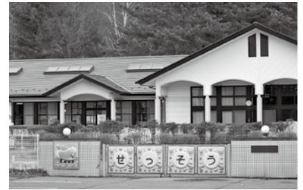
令和6年度に改修予定の雪窓保育園。
