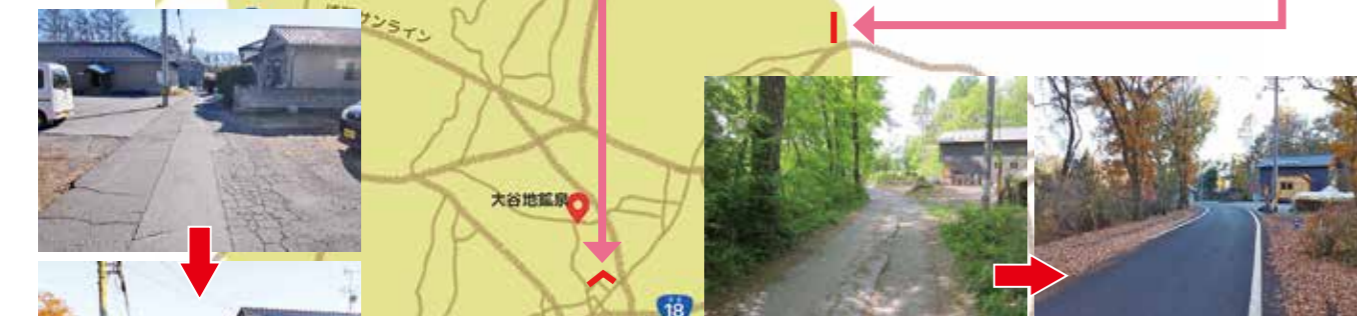
東台20号線 道路改良工事(西軽井沢地区) 幅員3.0(4.0)m 延長149.0m
