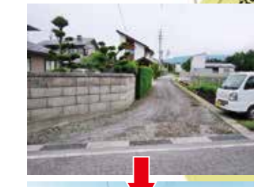
東原郷戸線 道路改良工事(馬瀬口地区) 幅員2.7(3.7)m 延長152.0m
