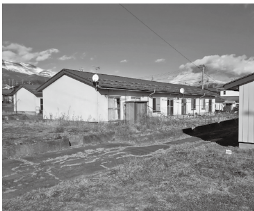
解体予定の町営住宅
